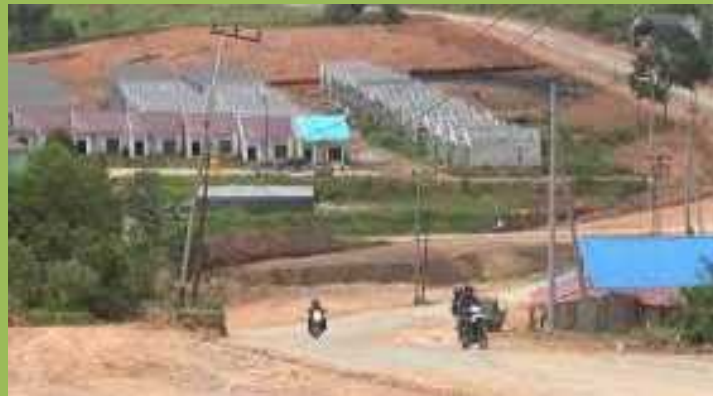
Jalan Sepingan Baru – Km 8
